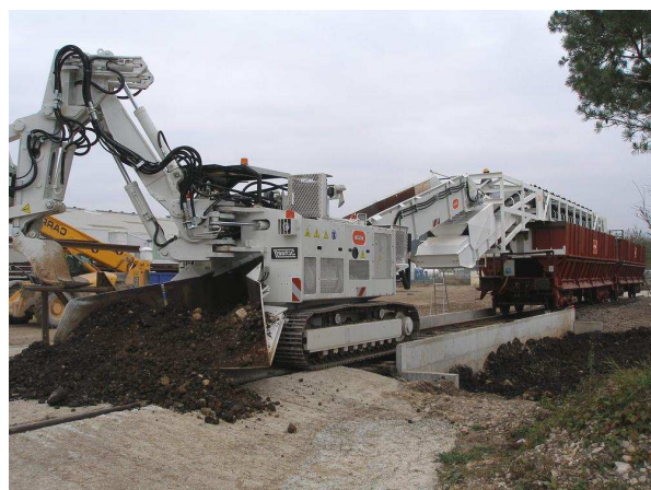
Pelle Schaeff et wagons d'évacuation des déblais
