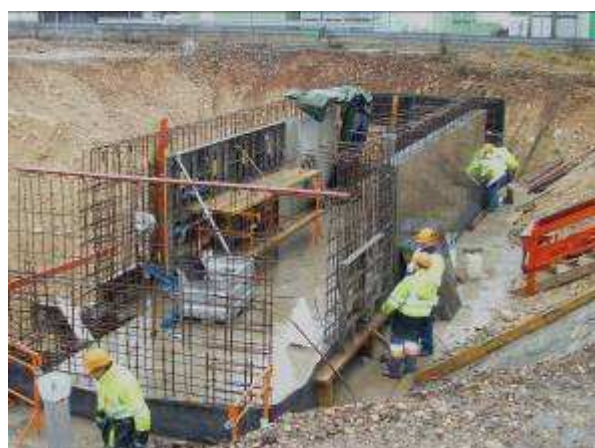
Passage souterrain gare de Nurieux-Volognat
